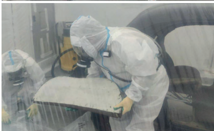
Retrait de l'amiante par une entreprise spécialisée © Sylvie Maillard
